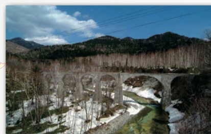
第五音更川橋梁
