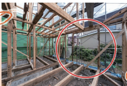
特に傷みの激しい部分は、木材を交換します。 交換状況です。
