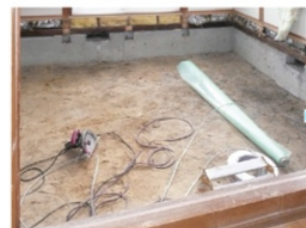
床・梁などを撤去し、構造部分を含め断熱の改修を行っています。この状態は通常リフォームですが、これが全室となるとリノベーションです。
