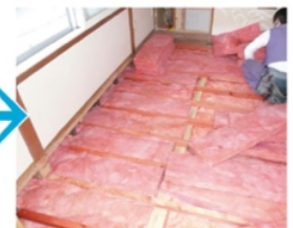
床・梁などを撤去し、構造部分を含め断熱の改修を行っています。この状態は通常リフォームですが、これが全室となるとリノベーションです。
