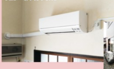
実際の取り付け状況
